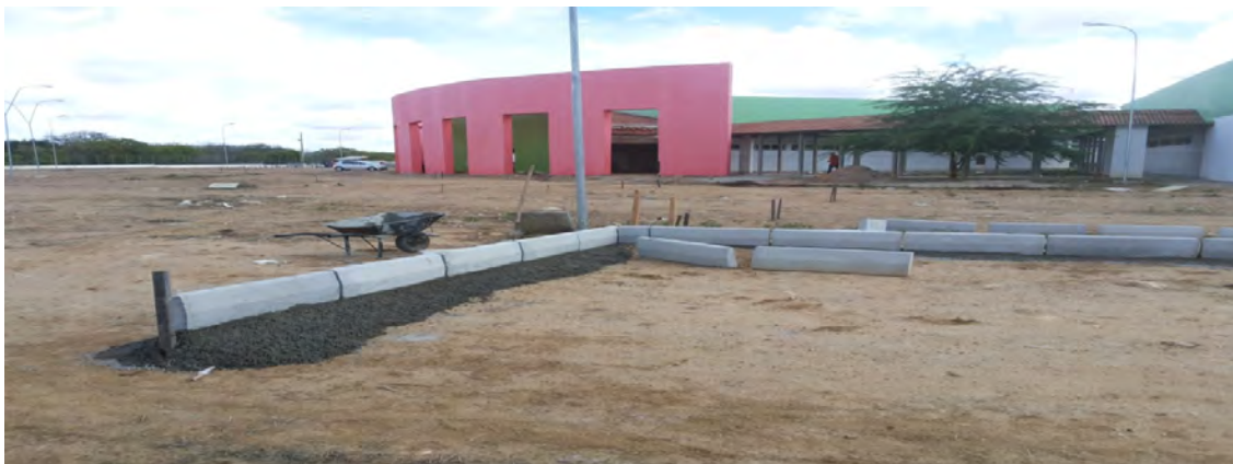
Figura 14: Canteiro de obras do campus Nossa Senhora da Glória
