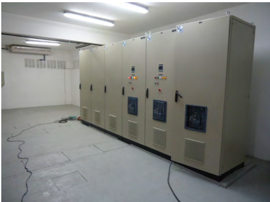
Figura 13: Subestação no campus Aracaju, obra de reforma elétrica Fonte: DIPOP
