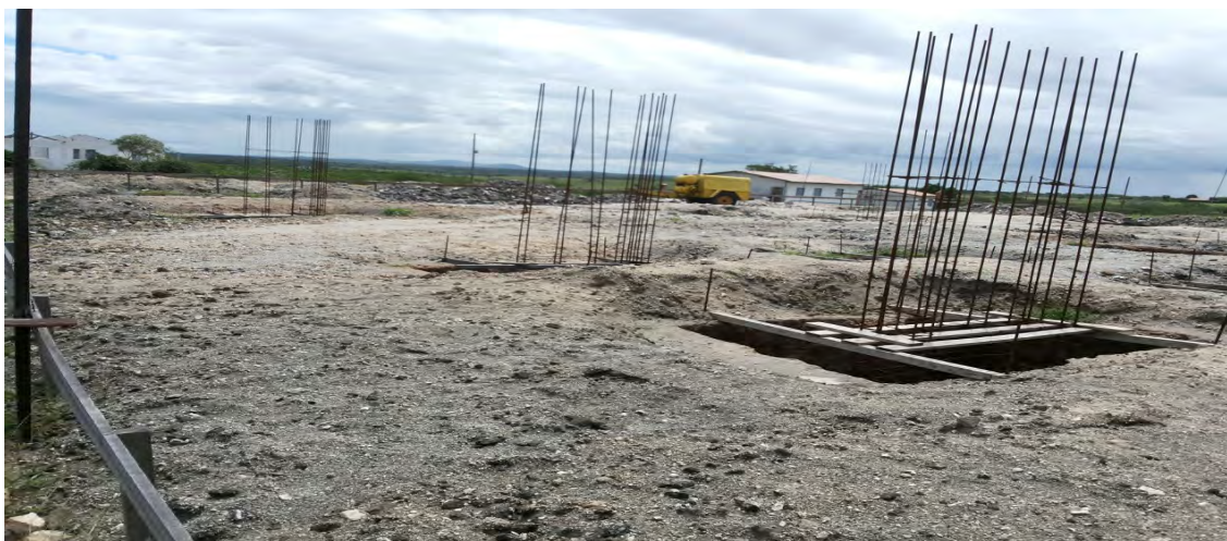
Figura 30: Canteiro de obras do campus Poço Redondo
