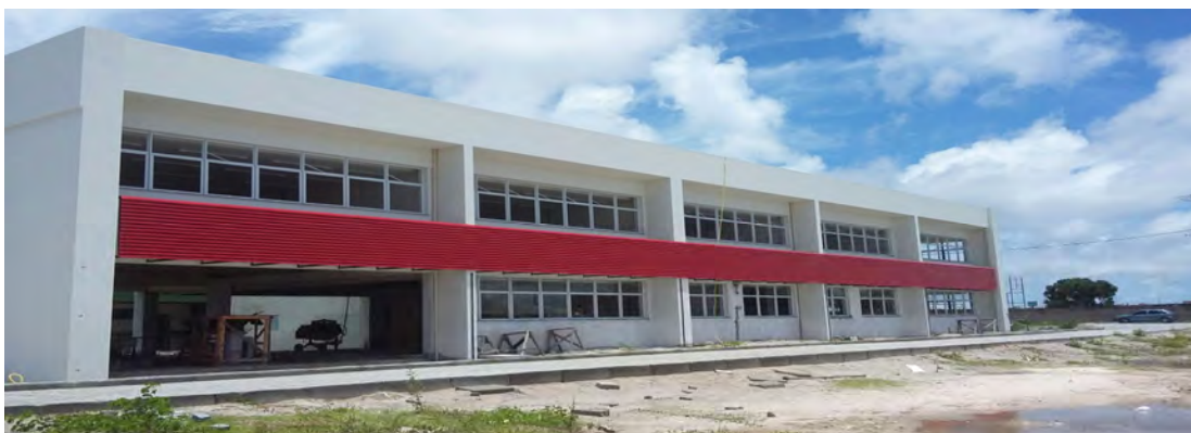
Figura 25: Canteiro de obras do campus Nossa Senhora do Socorro Fonte: DIPOP
