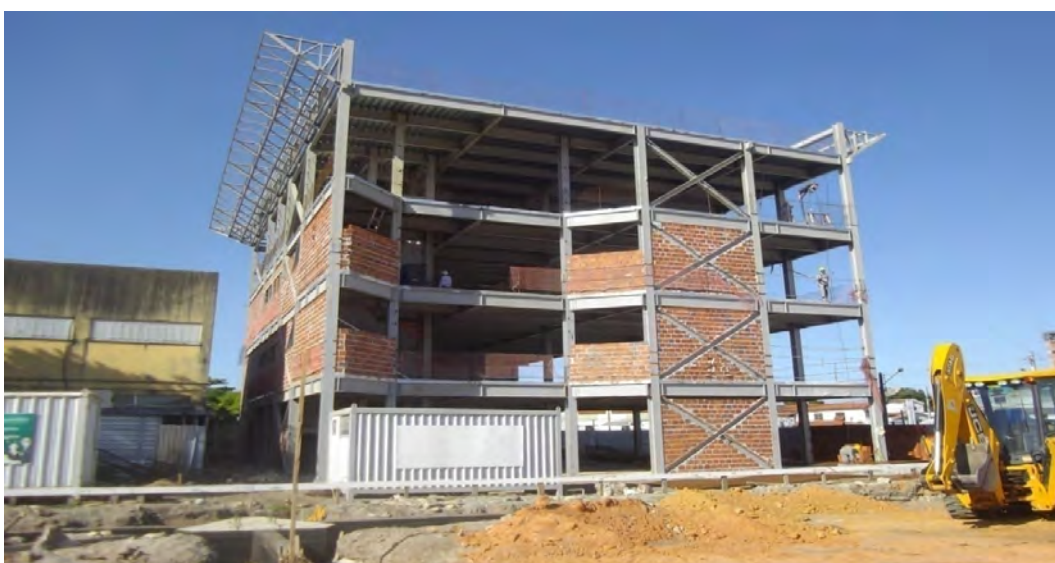
Figura 38: Canteiro das obras de ampliação e reestruturação do campus Aracaju (B) Fonte: DIPOP
