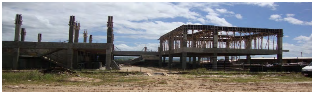
Figura 22: Execução de serviços no canteiro de obras do campus Tobias Barreto
