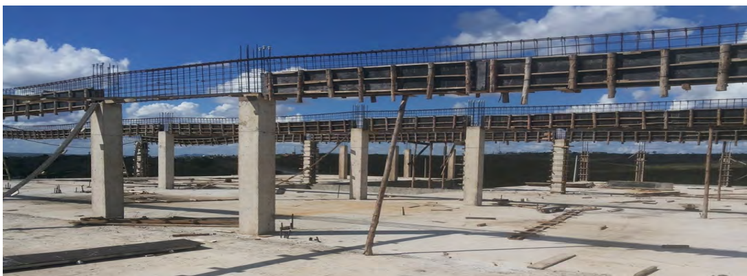
Figura 28: Canteiro de obras do campus Propriá
