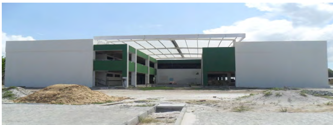
Figura 24: Canteiro de obras do campus Nossa S enhora do S ocorro
