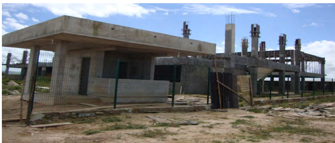
Figura 21: Execução de serviços no canteiro de obras do campus Tobias Barreto
