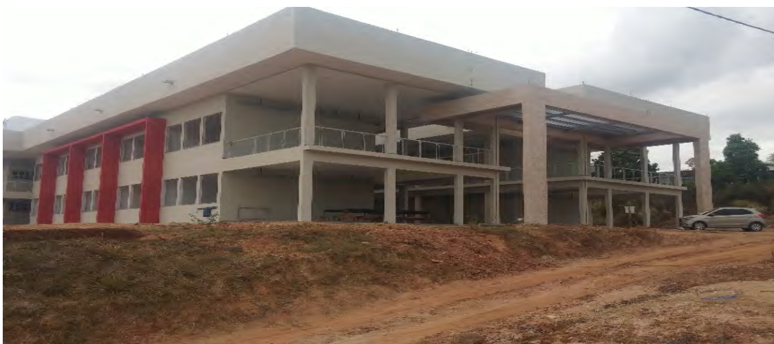
Figura 17: Obras do bloco Didático do campus São Cristóvão Fonte: DIPOP
