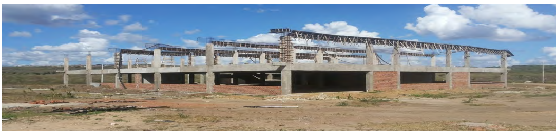
Figura 27: Canteiro de obras do campus Propriá Fonte: DIPOP
