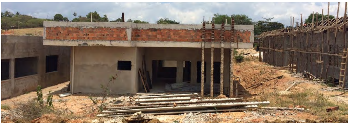
Figura 15: Canteiro de obras dos Alojamentos e Posto Médico do campus São Cristóvão
