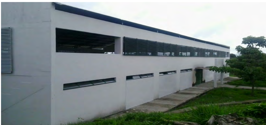
Figura 41: Canteiro das obras de reforma do ginásio poliesportivo do campus Lagarto
