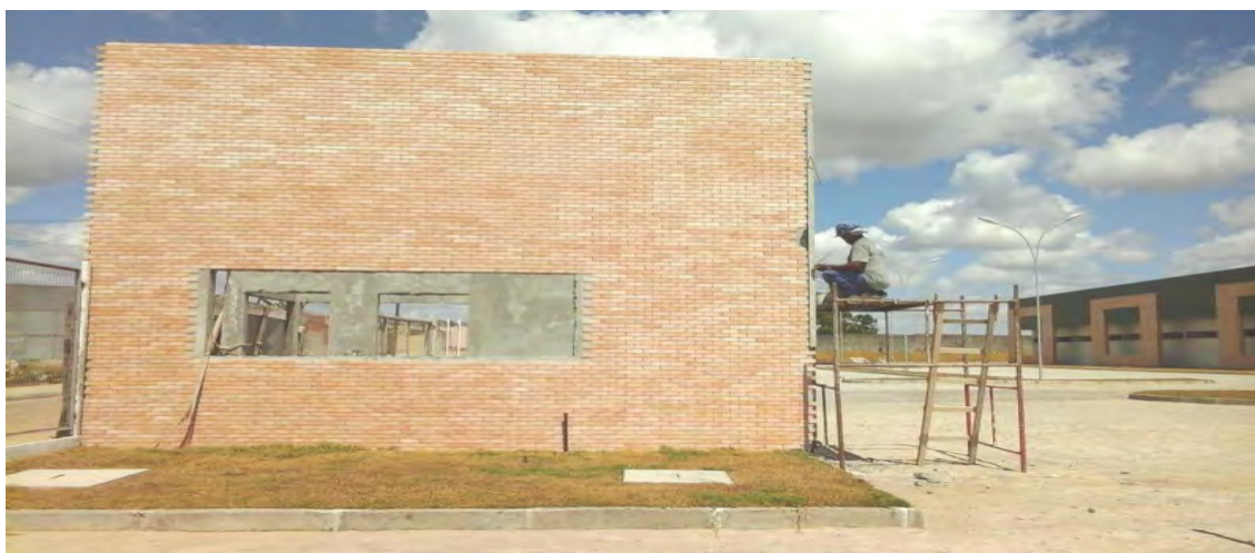
Figura 32: Canteiro de obras do campus Itabaiana (A) Fonte: DIPOP
