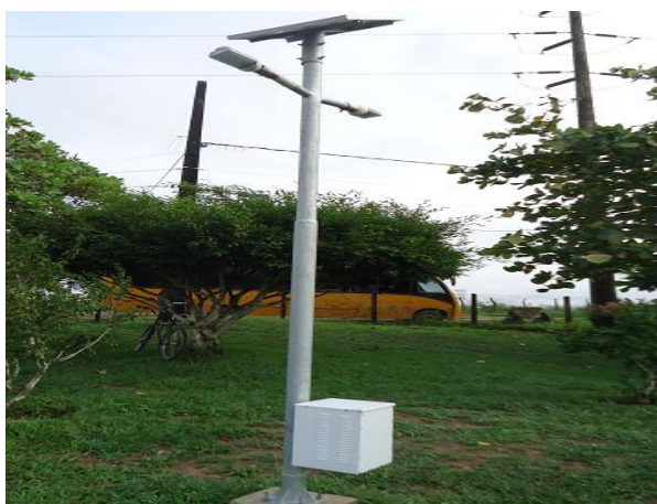
Figura 27 – Poste para aproveitamento de energia solar.
