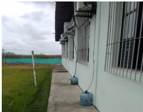
Figura 43 – Reutilização da água dos aparelhos de ar condicionado
