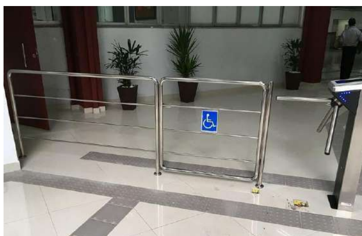
Figura 9 – Delimitadores de aço inox com catraca para o refeitório.
