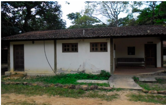
Figura 3 – Sede administrativa do RVS-MJ.
