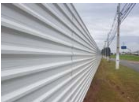
Figura 4 - Tapume com telha metálica
