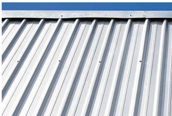
Figura 6 - Fechamento vertical com telha
