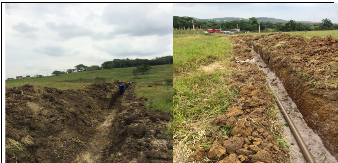
Implementação do sistema de abastecimento de água do campus São Cristóvão. Fonte: acervo DIPOP.
