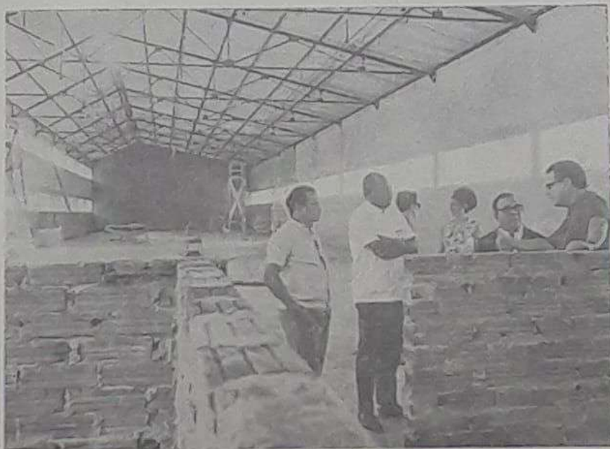
Visita a Belém — Visitando a Escola Técnica Federal do Pará, o Diretor do Ensino Industrial, Prof. Jorge Alberto Furtado, percorre o pavilhão que está sendo construído.
