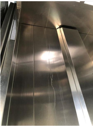
Água escorrendo pelo inox da parte interna da cabina
