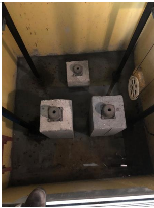
Água no fundo do poço
