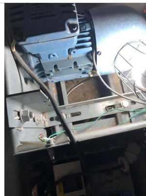
Água presente na base do motor
