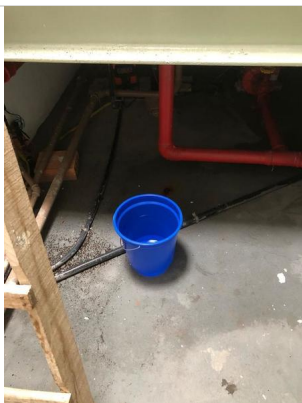
Laje com sinais de infiltração
